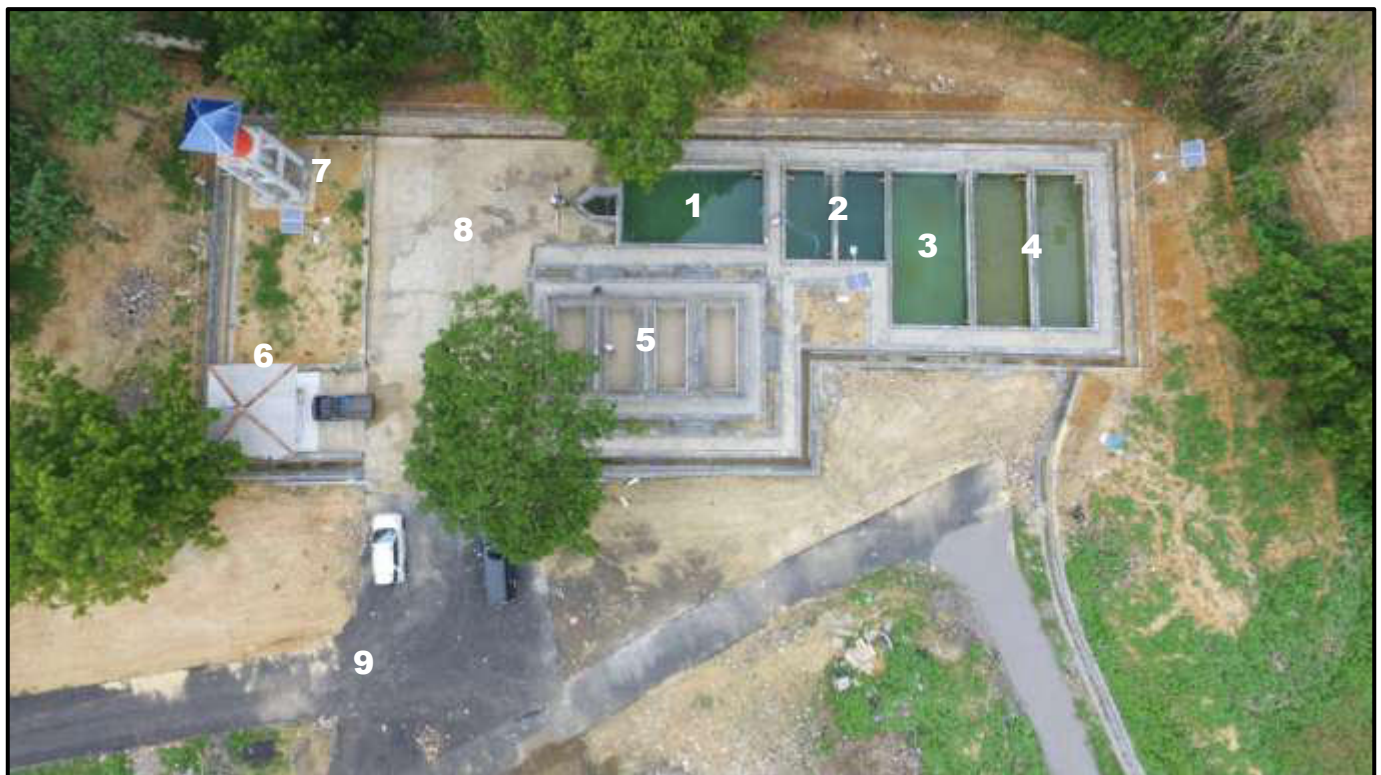
Sumber: Laporan Pembangunan IPLT, 2016
