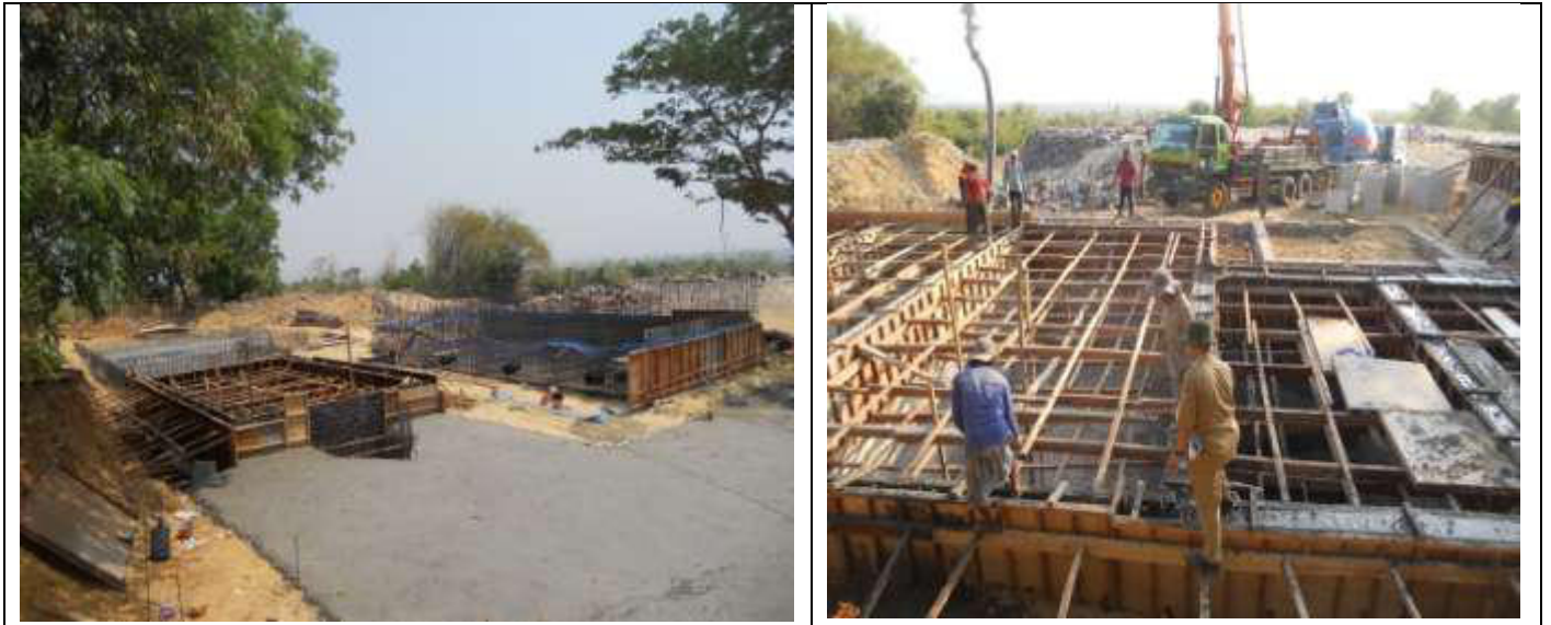
Sumber: Laporan Pembangunan IPLT, 2016
